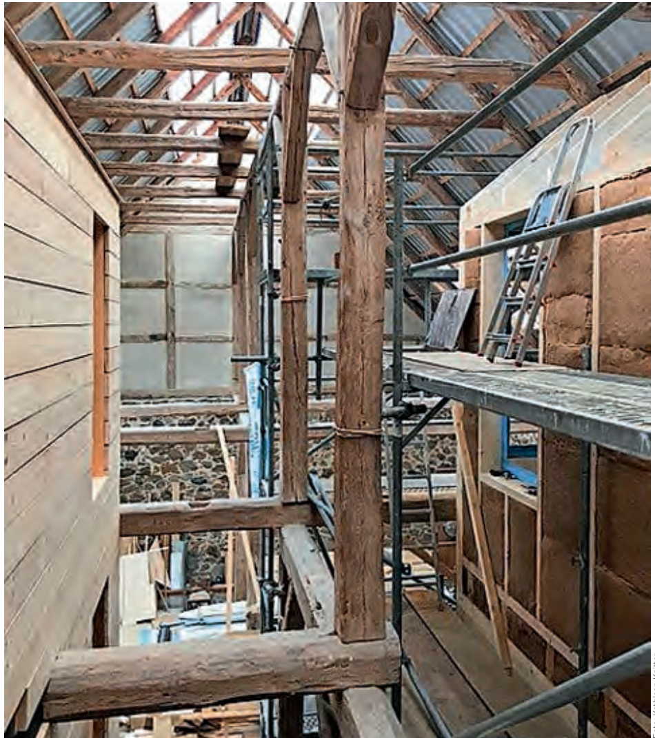
Umbau einer alten Scheune zum Wohnhaus, Haus im Haus, Holzbauten, im Bau, Prignitz
