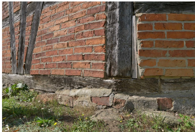
1. Altar heute an der Nordseite - 2. Die Winterkirche - 3. Schadhafte Fachwerkschwelle - 4. Abplatzungen des Putze durch Feuchteschäden
