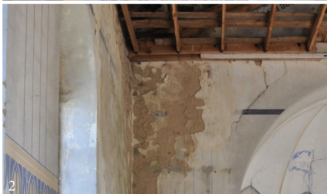
1. Blick in den Chor - 2. Putzabplatzungen durch Feuchteschäden - 3. Art-Déco-Bemalung aus den 1920ern - 4. Ziegelmuster im Fußboden - 5. Fehlerhafte Auflasten der Dachträger
