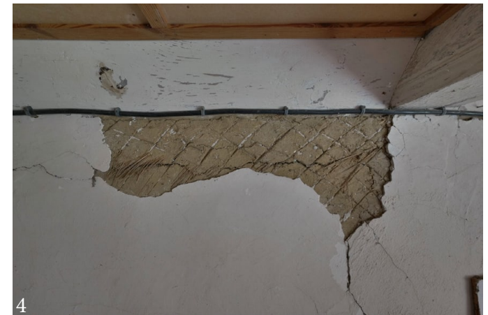
1. Altar heute an der Nordseite - 2. Die Winterkirche - 3. Schadhafte Fachwerkschwelle - 4. Abplatzungen des Putze durch Feuchteschäden
