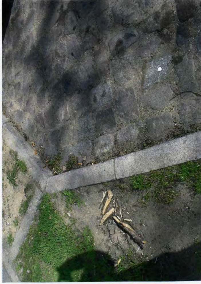
Parknische mit Pflaster- u. Bordsteinen
