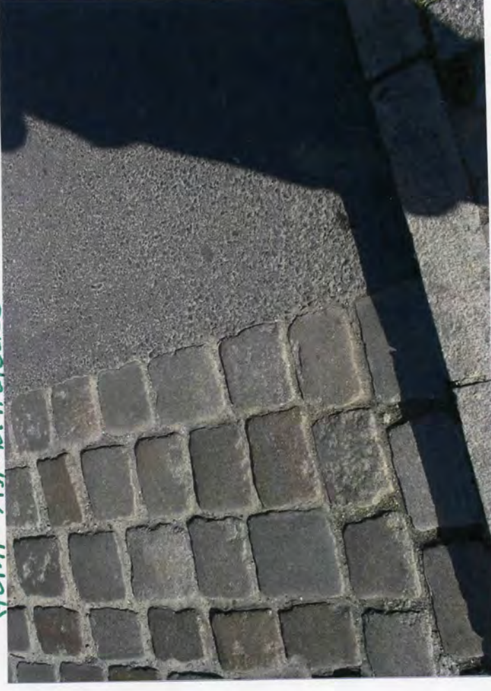
Großsteinpflaster, Asphaltdecke, Bordstein
