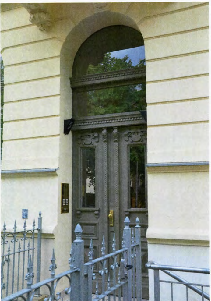
Tür mit Oberlichtfenster, schmiedeeiserner Zaun
