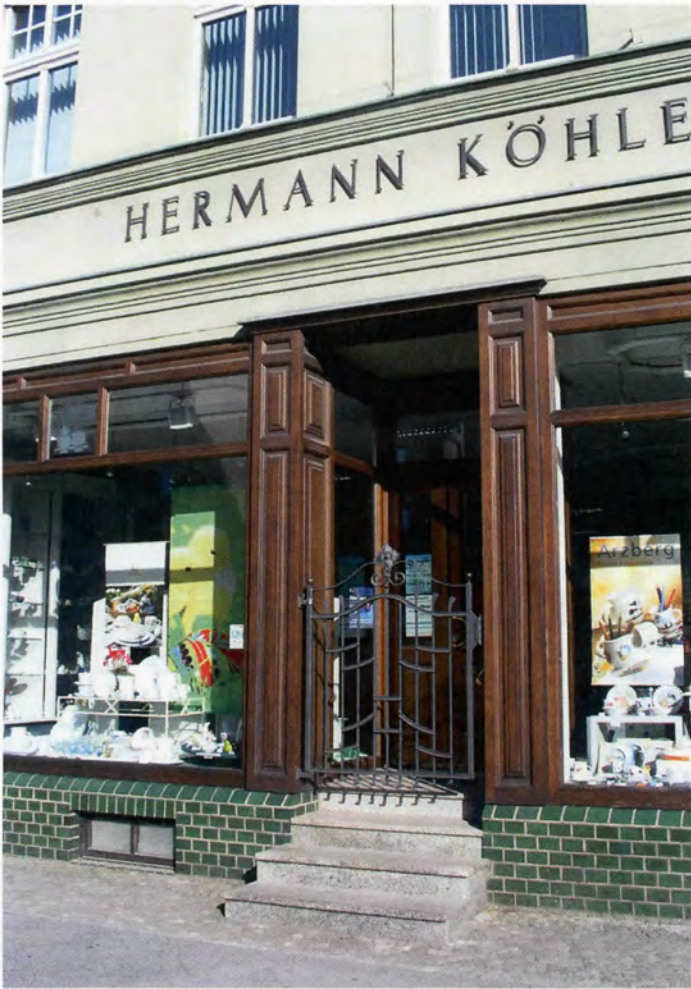
grüne, glasierte Klinker im Sockelbereich
