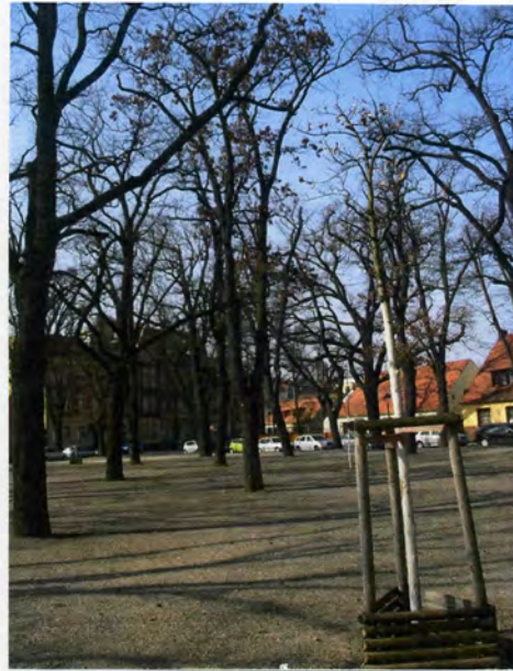
Gemisch von Kies, Sand, Lehm Fachbegriff: wassergebundene Decke
