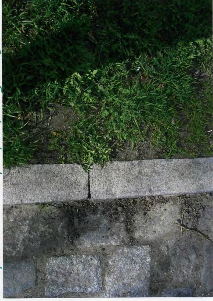
Großpflaster, Bordstein, Rasen
