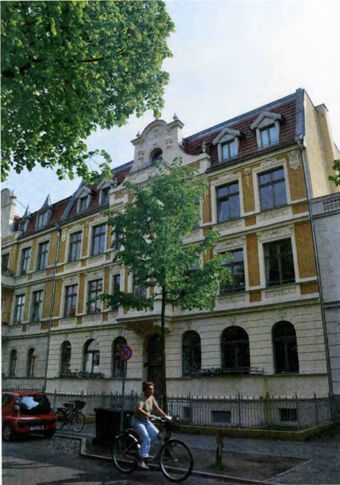
Rundbogenfenster im Erdgeschoss
