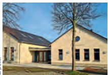
Foto: architekturbüro fiedler & peter
